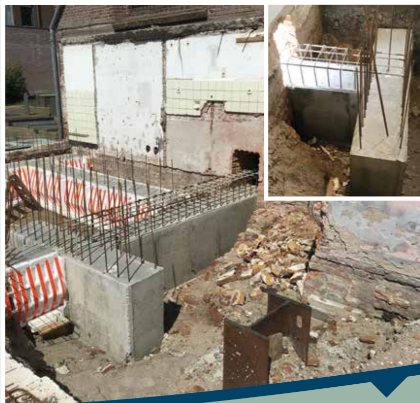
Funderingsbalk binnen en buiten de kerk
